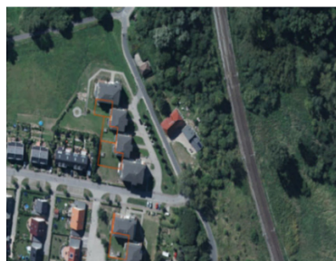
Abbildung 6: Oberflächlich begrünte Tiefgarage
