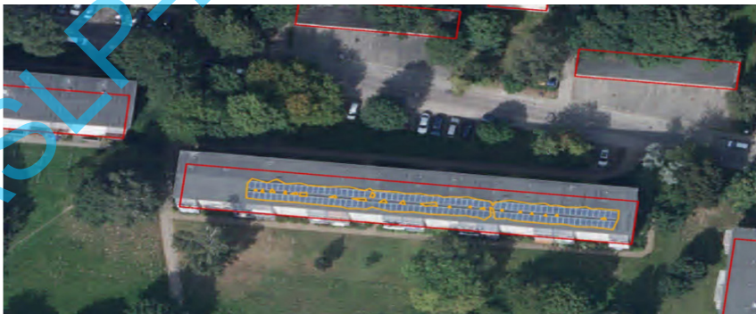
Abbildung 9: Automatisch klassifizierte Solarpanels auf einem Flachdach
