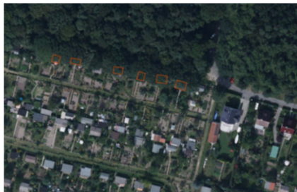
Abbildung 1: Vollständige Übershirmungen der Dächer durch Bäume
