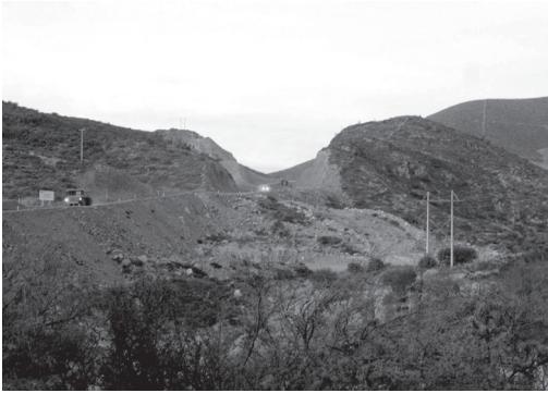
Figura 20. Demolición y muerte del Cerro de San Pedro.
